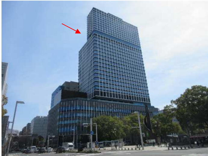
中日ビル建替(令和6年4月開業)
