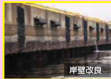
岸壁の老朽化対策
