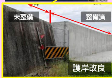
防潮壁の防災機能強化
