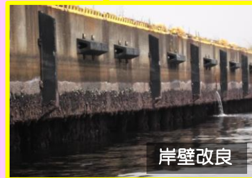
岸壁の老朽化対策
