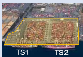
飛島ふ頭南側コンテナターミナル
