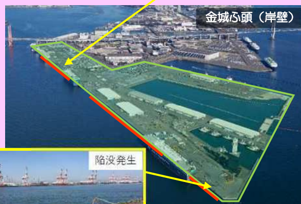
岸壁の老朽化対策
