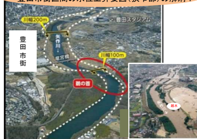
矢作川（国）渡合地区（鵜の首）河道掘削
