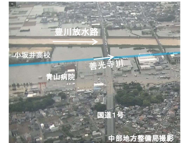
2023年6月2日豪雨 豊川市浸水状況
