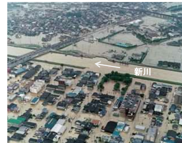
2000年9月12日東海豪雨 清須市浸水状況
