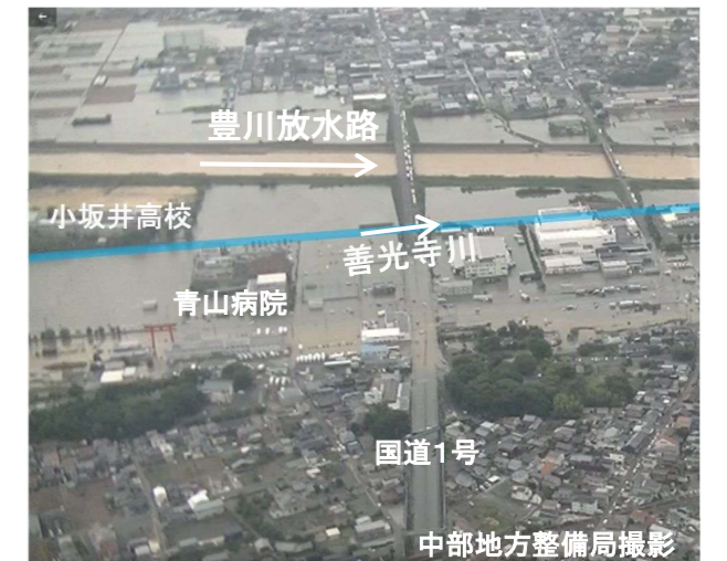
2023年6月2日豪雨 豊川市浸水状況
