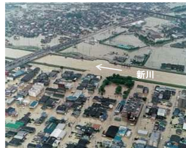
2000年9月12日東海豪雨 清須市浸水状況
