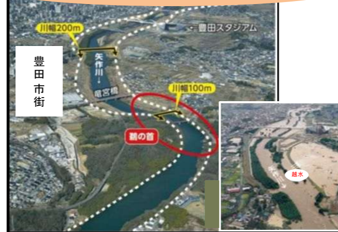
矢作川（国）渡合地区（鶴の首）河道掘削
